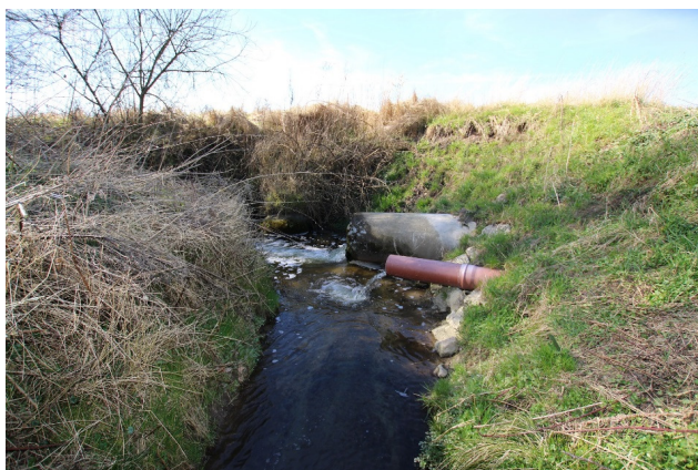
Figur 62: Udløb fra Vissenbjerg Renseanlæg, hvor røret peger i nedstrøms retning.
