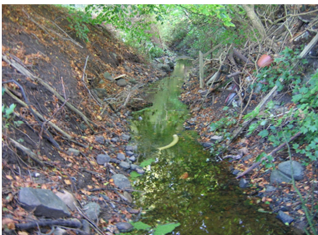
Figur 5: Opstrøms privat bro. Der er en del affald og byggematerialer, sandsynligvis stammende fra privat have.
