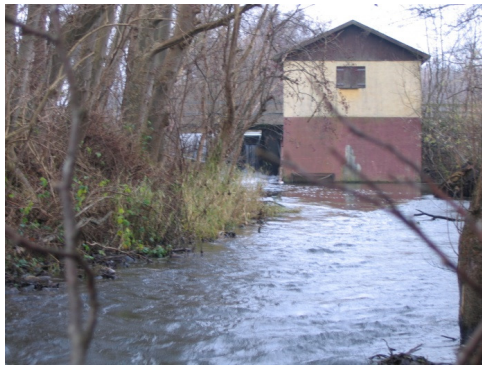
Figur 32: Vandløbet set opstrøms for stationen med stemmeværket.
